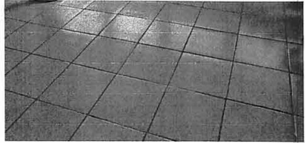
Foto 2: Reparación de piso cerámico.
