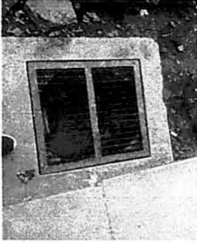
Foto1: Reparación de drenaje mal colocado.
