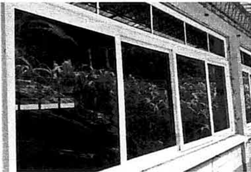
Foto 5: Mantiniemiento de Balcones, (Limpieza y pintura)
