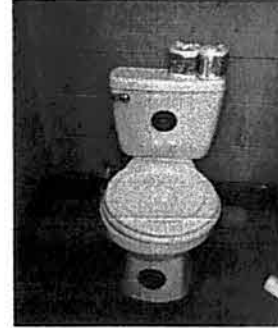
Foto 2: Reparación de letrinas.
