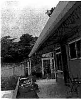
Foto 3: Reposición de canales en cocina y sus respectivas bajadas de agua.
